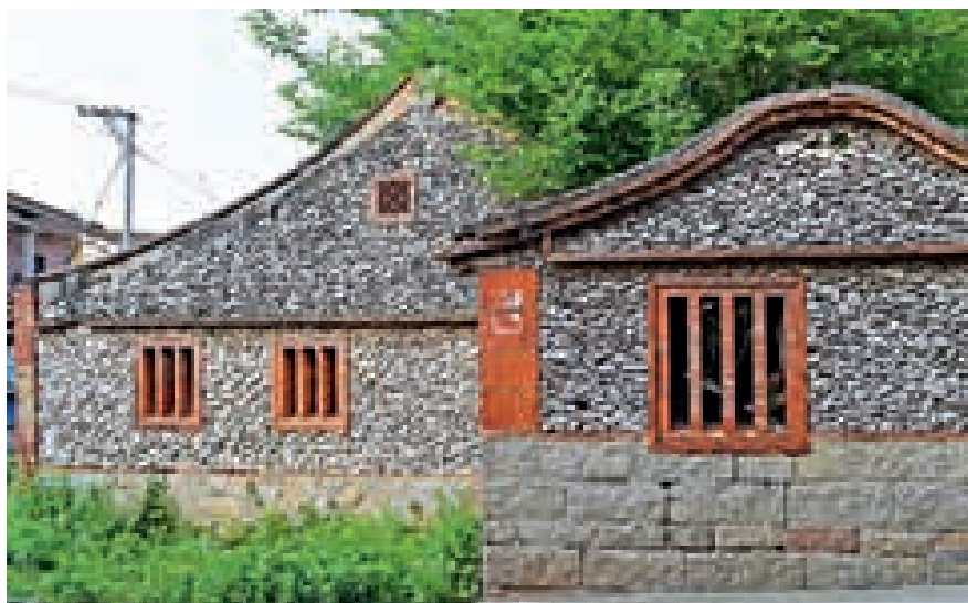
当地极具特色的民居蚵壳厝——用海蛎壳拌海泥筑起的房屋
